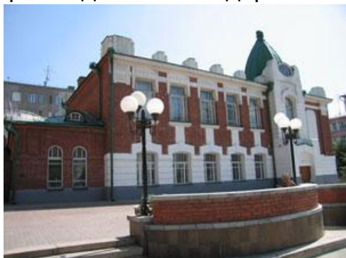
Городская начальная школа на углу улиц Ленина и Революции. Здание искажено перестройкой под театр кукол
